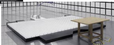
吸収体設置完了
