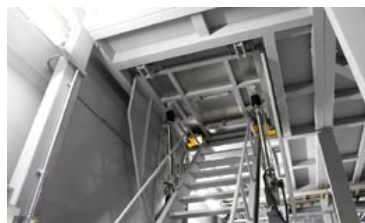
ビット側から見た昇降階段。安全性に徹した電動開閉機構です。
