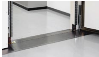
開口部がシールドされたバリアフリーの床面となります。
