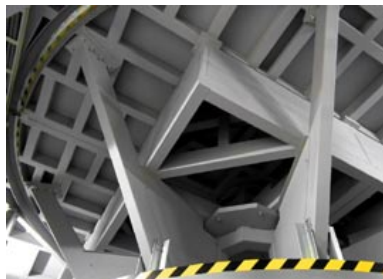
ビットから見上げた下部構造。この構造部全体が回転する新方式です。
